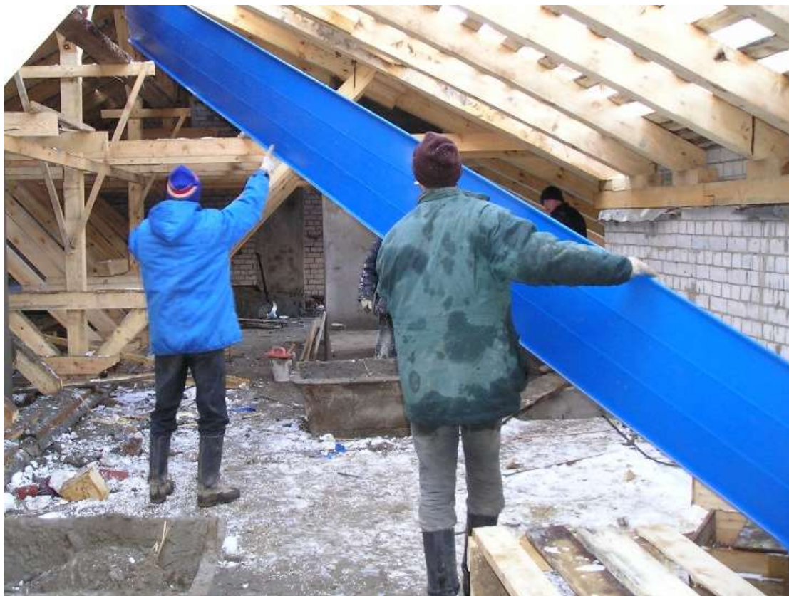
Кровельные панели подаём на кровлю
